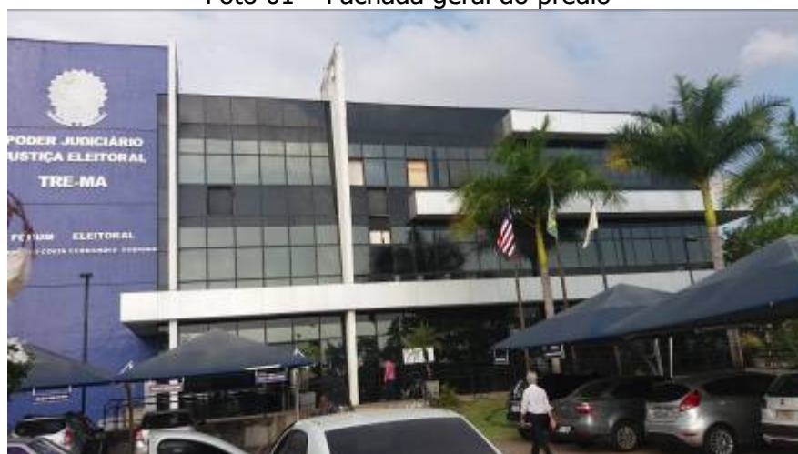
Foto 02 – Fachada da Administração (área de intervenção)
