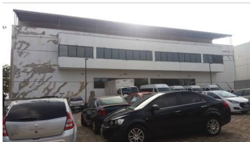
Foto 03 – Fachada dos fundos da Administração (área de intervenção)
