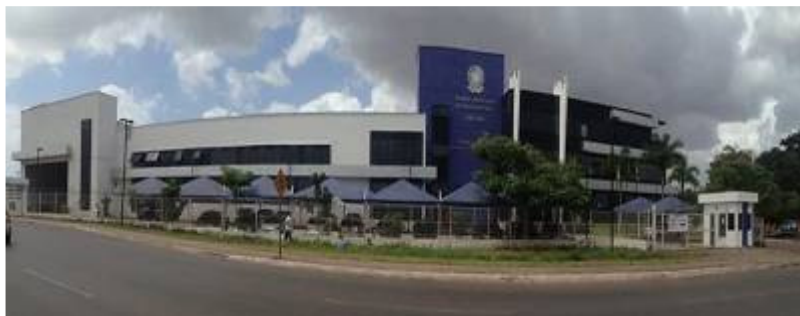
Foto 01 – Fachada geral do prédio
